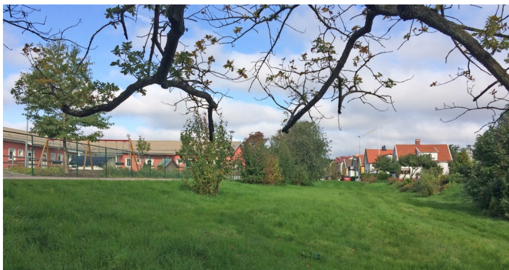
Figur 5. Nuvarande förskola och dagvattendike öster om byggnaden, sett från sydöst.
